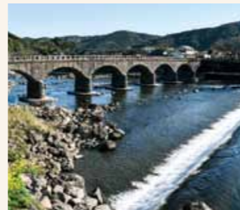
写真：耶馬溪橋
