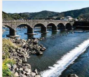
写真：耶馬溪橋
